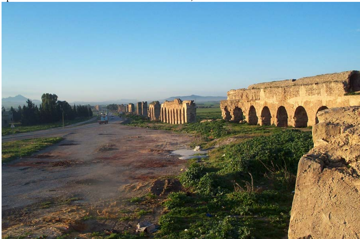
L'aqueduc de Zaghouan
